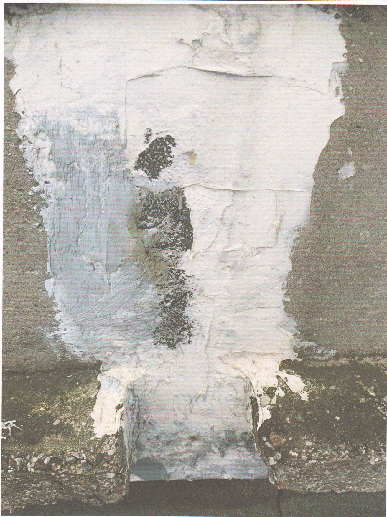
Фото 6. Герметизация межпанельных швов
