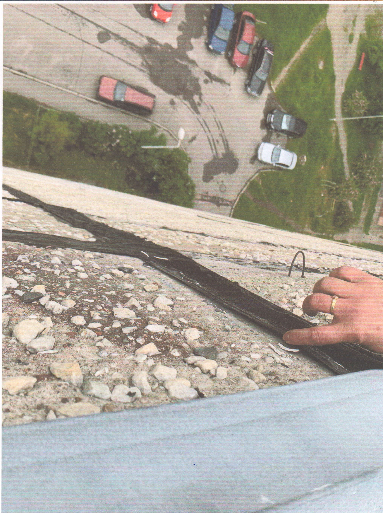
Фото 5. Герметизация межпанельных швов
