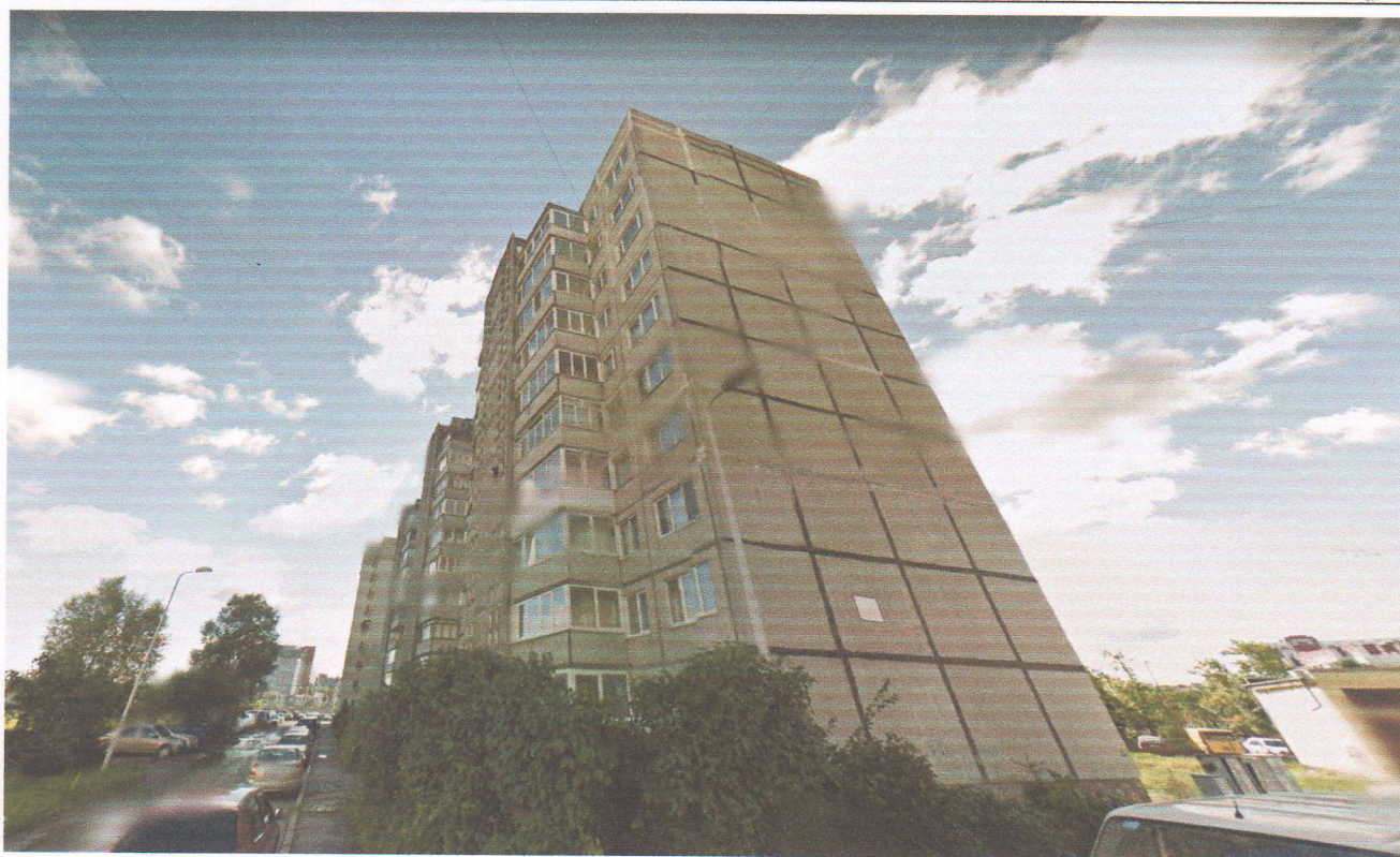
Фото 3. Правый торцевой фасад здания
