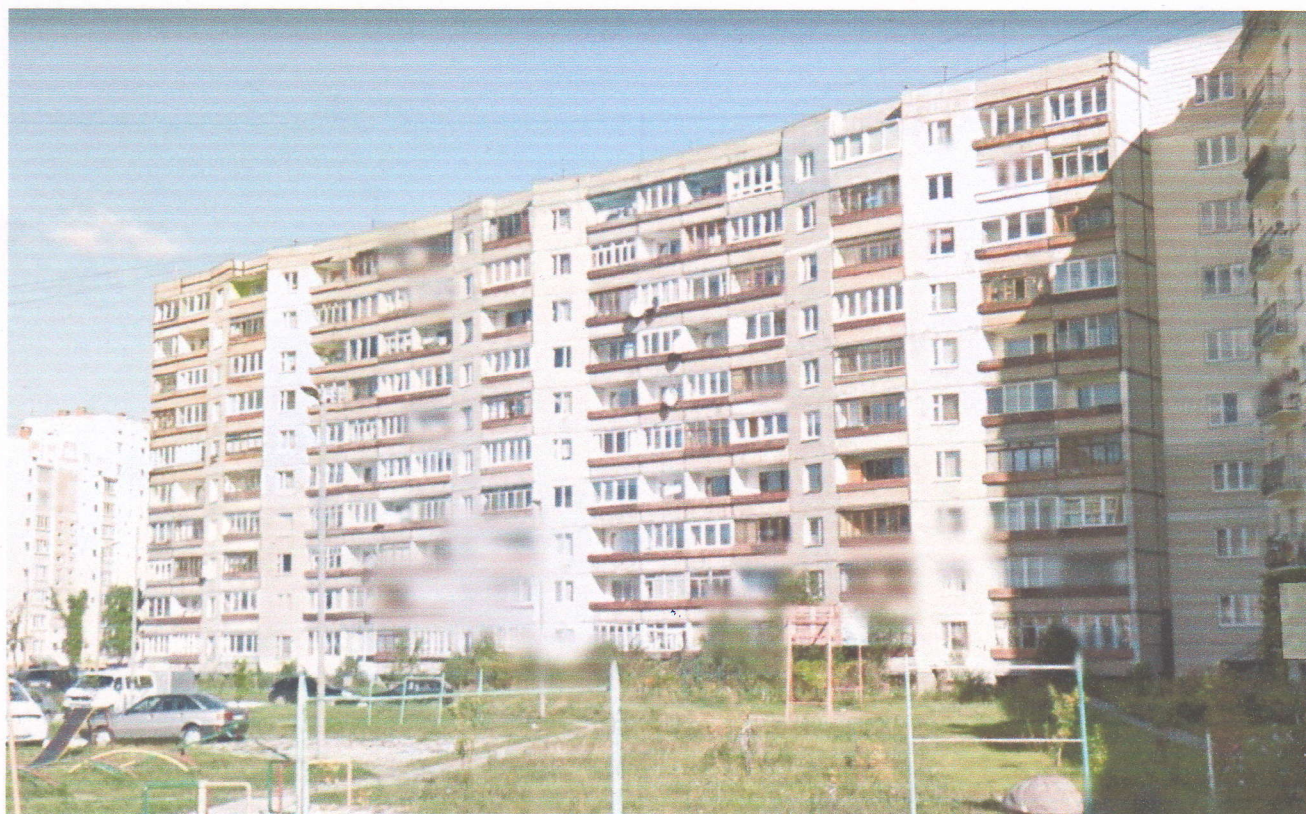
Фото 2. Дворовой фасад здания
